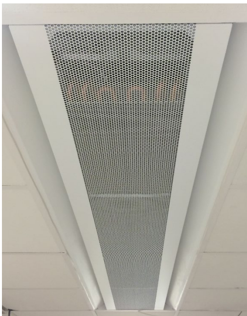
Bild 1 Kylbaffel monterad i undertak.
